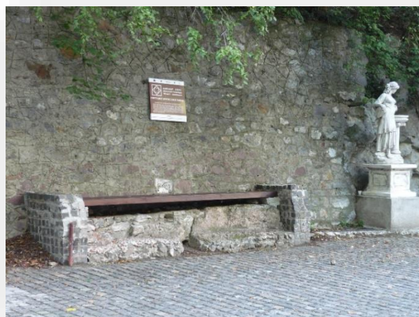
Vestigiile apeductului roman situat pe Strada Romană, Băile Herculane
