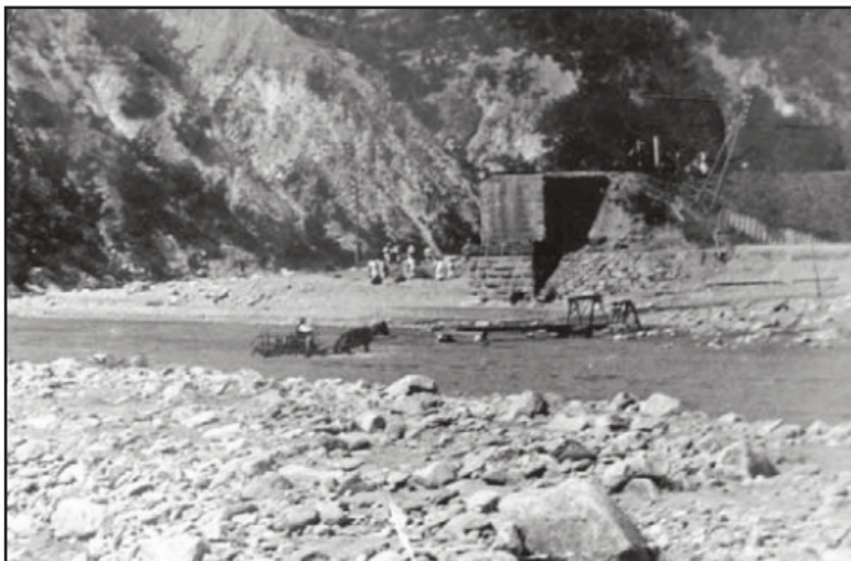
Vechiul pod de la intrarea sudică în Mehadia, distrus de apele învolburate
